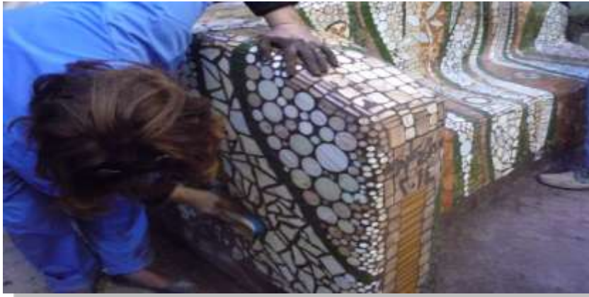
شكل رقم ( ٣٤ ) اثناء فرك بودرة الرخام لتلميع السيراميك وازالة المعجون العالق على السطح
