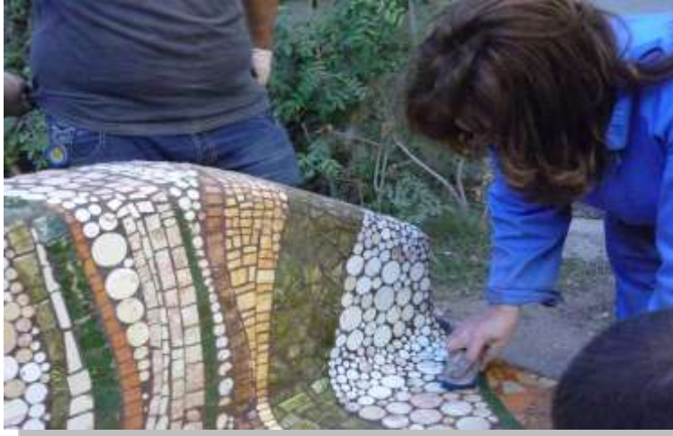
شكل رقم ( ٣٦ ) اثناء عملية فرك وتلميع السطح باستخدام فرشاة بلاستيكية خشنة نوعا ما ( فرشاه بلاط)
