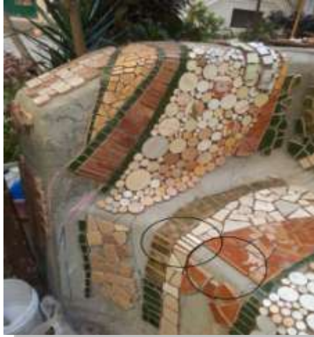
شكل (١٥) يبين كيفية تركيب قطع السيراميك على منحنيات العمل
