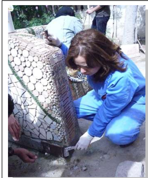
شكل رقم ( ٣١ ) تركيب الاجزاء الاخيره من السيراميك
