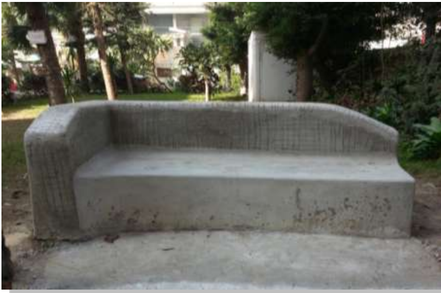
رقم (٢) أ بعد عملية المحارة وتخشين السطح
