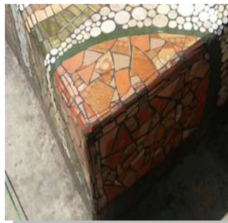
شكل (١٣) يوضح تغطية الزوايا بقطع السيراميك بعد قطع الزوايا الداخلية للبلاطات
