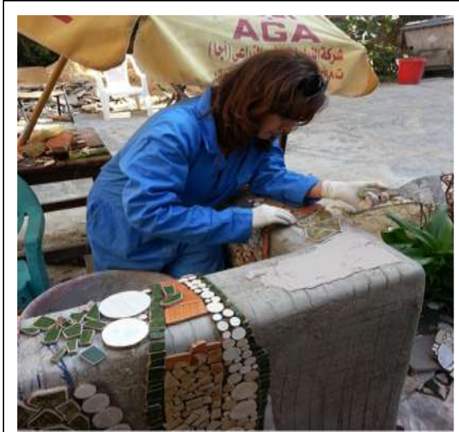
شكل رقم ( ٢٨ ) يبين طريقة فرد طبقة السيتوكس H تحت السيراميك
