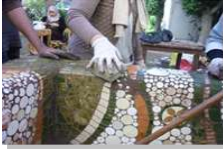
شكل رقم ( ٣٥ ) اثناء خلط المعجون الاسمнти لملء الفواصل
